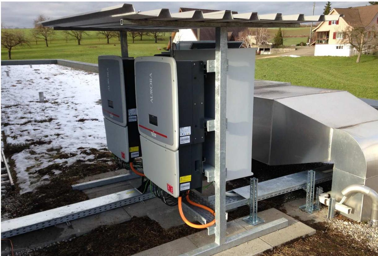
Abbildung 5 Wechselrichter mit Schaltschrank
