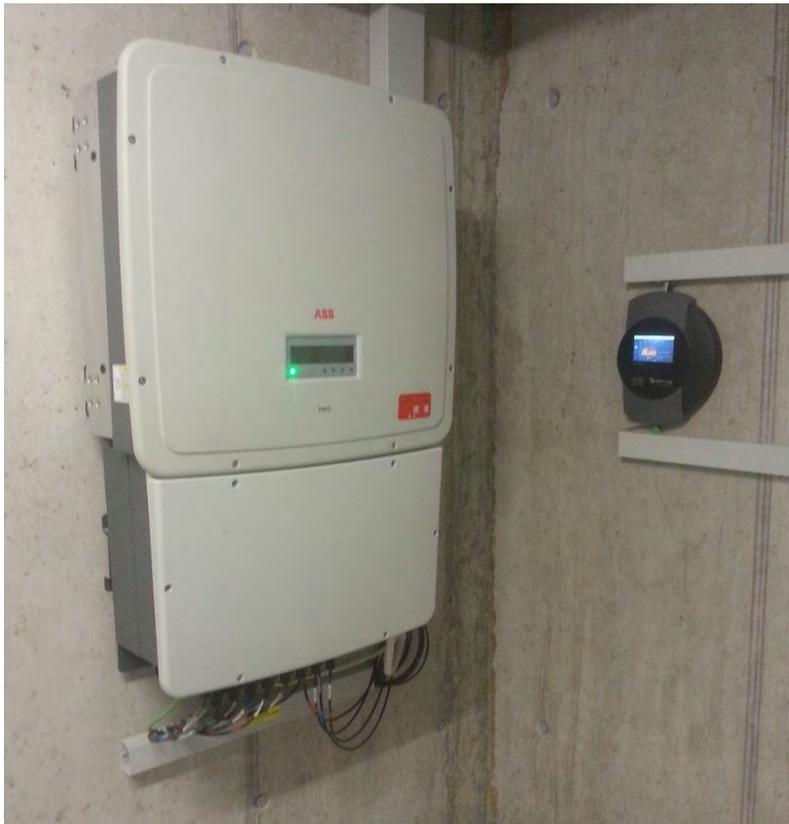
Abbildung 4: Wechselrichter mit Datenlogger inkl. Eigenverbrauchsermittlung
