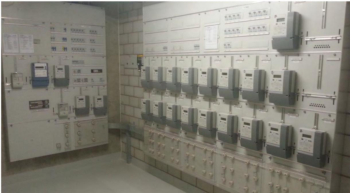
Abbildung 5: Tableau mit Haupt- und Unterverbrauchszähler
