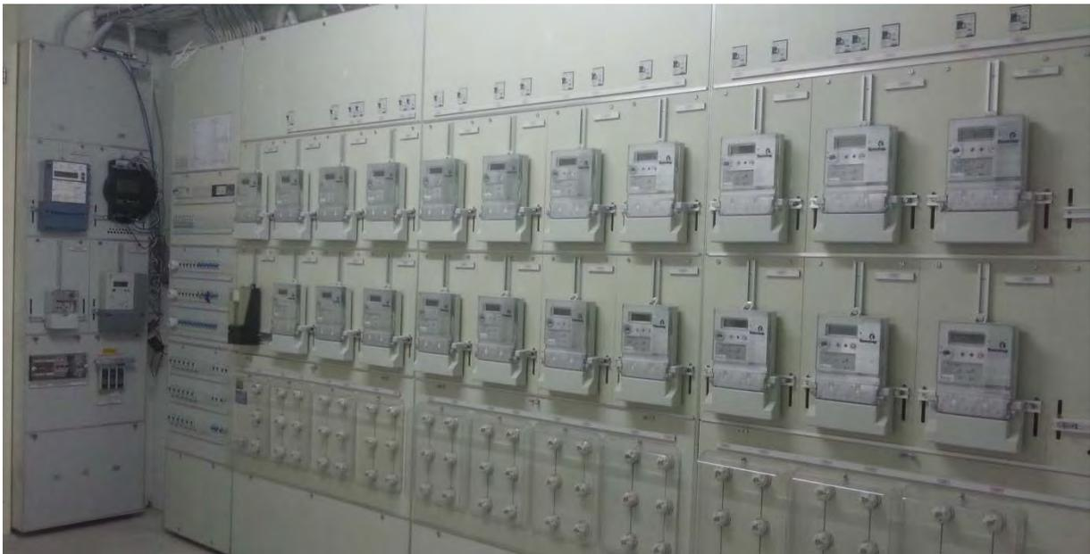
Abbildung 5: Tableau mit Haupt- und Unterverbrauchszähler
