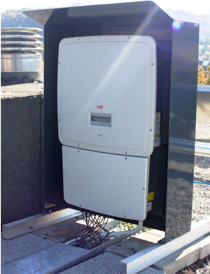
Abbildung 4: Wechselrichter mit Ständer im Freien aufgestellt.
